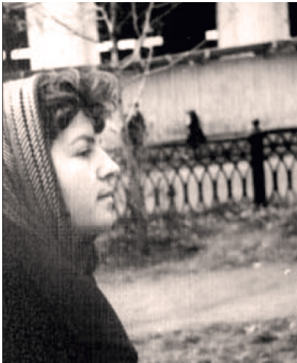
Сквер на ул. Гончарова с ныне не существующей чугунной изгородью
